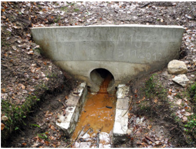
In Km 18,3 konnte der Durchlass fertiggestellt werden.
